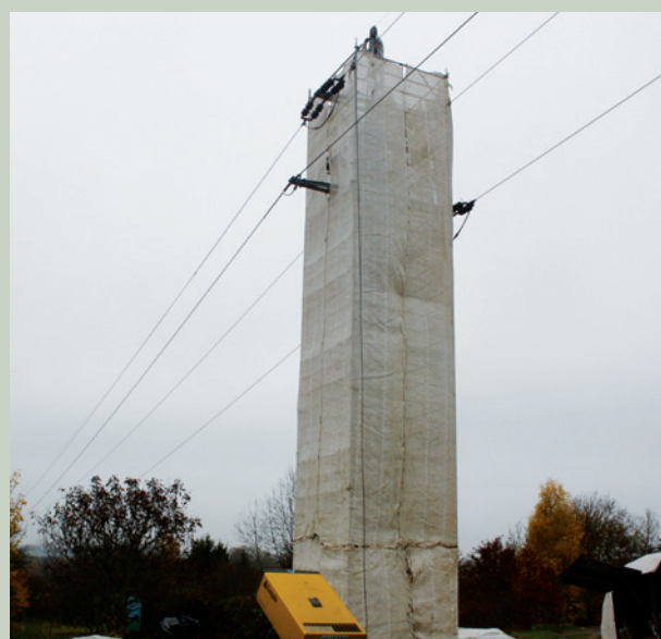
Freileitungsmastsanierung
